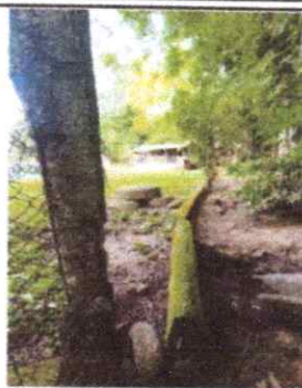
FOTO 2: REPARACION DE MURO PERIMETRAL
