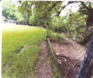
FOTO 1: REPARACION DE MURO PERIMETRAL
