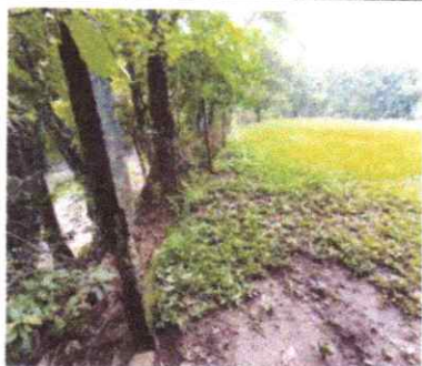
FOTO 3: REPARACION DE MURO PERIMETRAL
