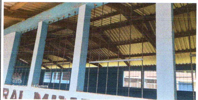
Foto 4: MANTENIMIENTO DE BALCONES DE METAL
