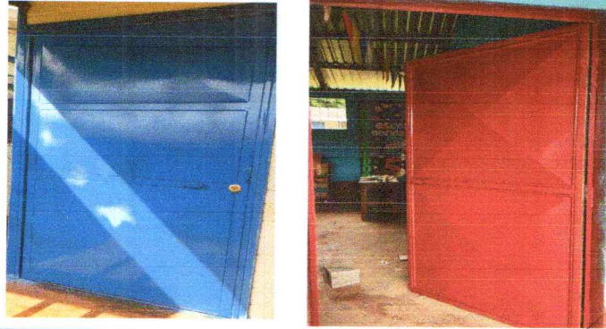
Foto1: SUSTITUCION DE CHAPAS Y PINTADA DE PUERTAS
