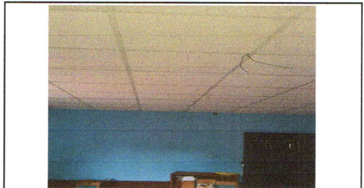
Foto 2: REMODELACION DE CIELO FALSO EN LA DIRECCION
