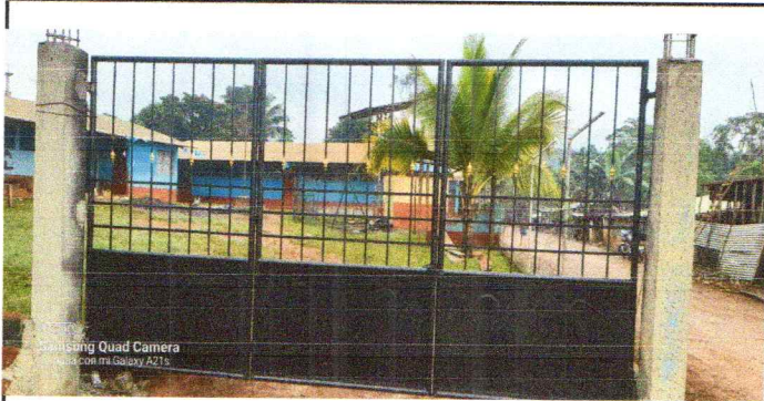
Foto 3: SUSTITUCION DE PORTON DE METAL
