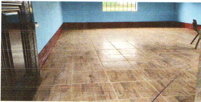
Foto 5: REPARACION DE PISO CERRAMICA
