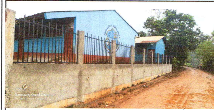
Foto 1: SUSTITUCION DE MURO PERIMETRAL DE BLOCK CON BARANDAS DE METAL
