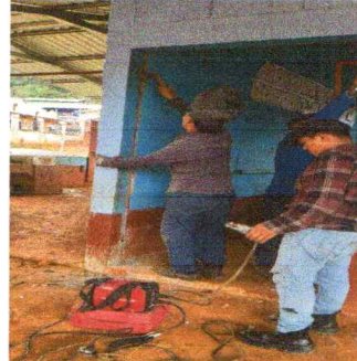
Foto 2: SUSTITUCION DE PUERTAS
