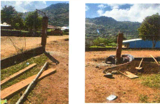
Foto 3: SUSTITUCION DE PORTON DE METAL
