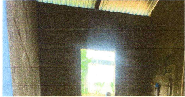
Foto 2: REMODELACION DE CIELO FALSO EN LA DIRECCION
