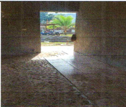
Foto 5: REPARACION DE PISO CERRAMICA
