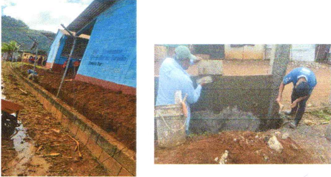
Foto1: SUSTITUCION DE MURO PERIMETRAL DE BLOCK CON BARANDAS DE METAL
