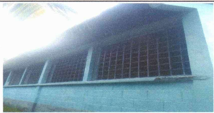
Foto 5: Sustrucción de estructura de metal de ventana y sustrucción de vidrios
