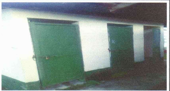
Foto 4: Sustrucción de puertas en servicios sanitarios
