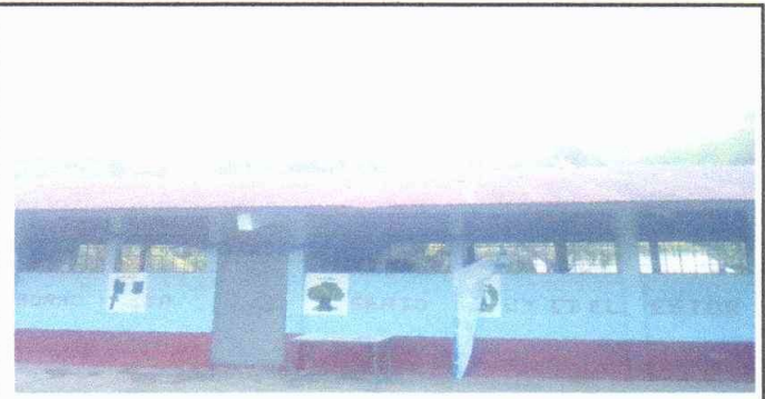
Foto 6: Pintura en muros exteriores e interiores
