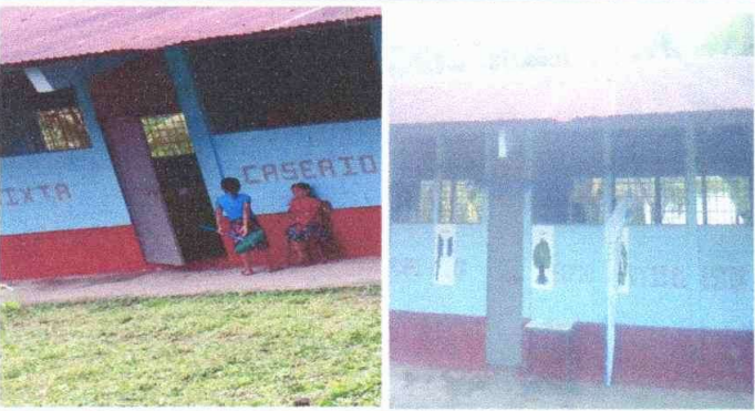
Foto 3: Sustrucción de puertas de metal
