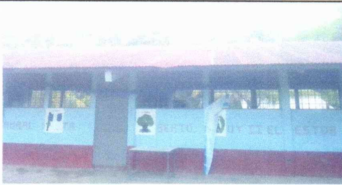
Foto 1: Sustrucción de láminas, por láminas troqueladas aluzinc calibre 26
