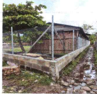
Foto 6: Reparación de Muro Perimetral
