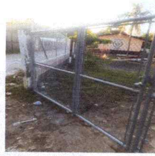
Foto 2: Reparación de Porton de Metal
