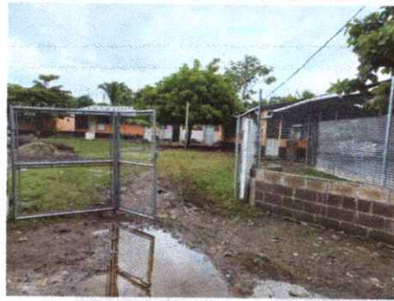
Foto 4: Reparación de Porton de Metal
