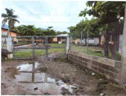
Foto 3: Reparación de Porton de Metal
