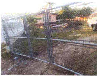
Foto1: Reparación del Porton de Metal
