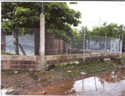
Foto 5: Reparación de Muro Perimetral
