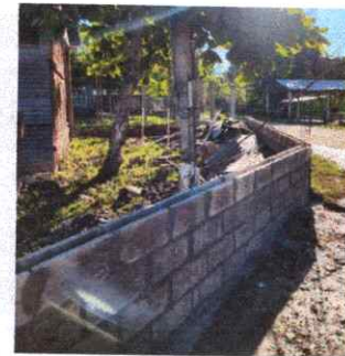
Foto 4: Reparación de Muro Perimetral
