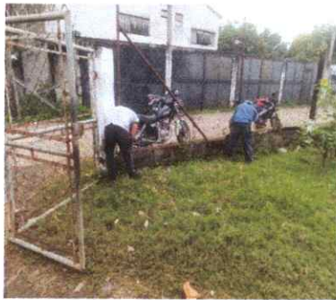
Foto 3: Reparación de Porton
