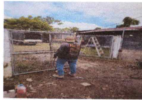
Foto 4: Reparación de Porton
