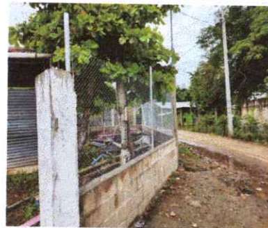
Foto 6: Reparación de Muro Perimetral
