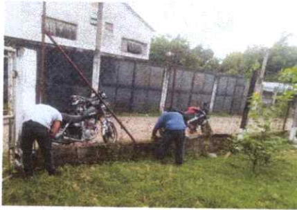
Foto1: Reparación Muro Perimetral
