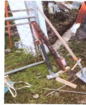
Foto 2: Reparación de Porton
