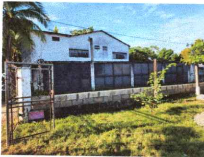
Foto 3: Reparación de Muro Perimetral
