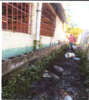
Foto 5: Reparación Muro Perimetral
