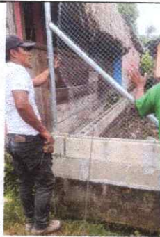
Foto 5: Reparación Muro Perimetral
