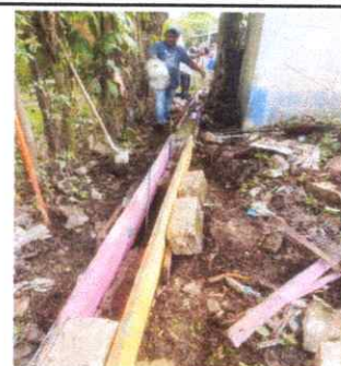
Foto 6: Reparación de Muro Perimetral
