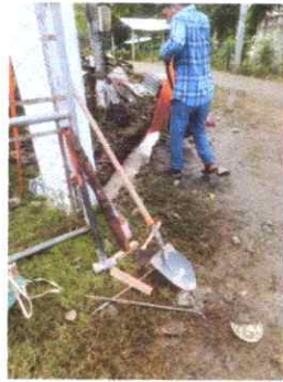
Foto1: Reparación de Porton
