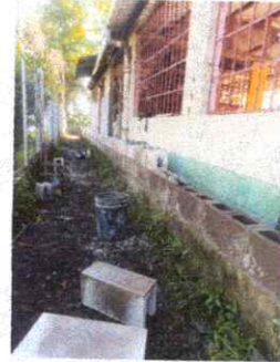
Foto 2: Reparación Muro Perimetral
