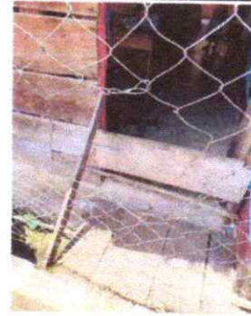
FOTO 4: REPARACION MURO PERIMETRAL
