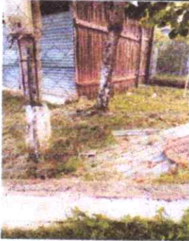
FOTO 3: REPARACION MURO PERIMETRAL
