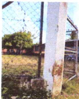
FOTO 5: REPARACION MURO PERIMETRAL
