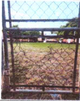
FOTO 1: SUSTITUCION DE PORTON DE METAL
