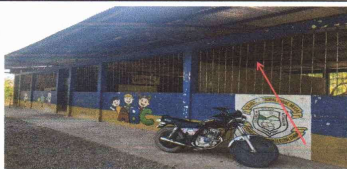
FOTO 4: Sustitución de balcones de metal
