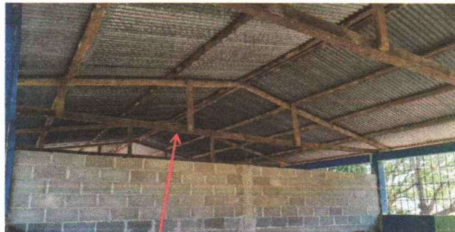
FOTO 2: Sustitución de soporte de madera por metal
