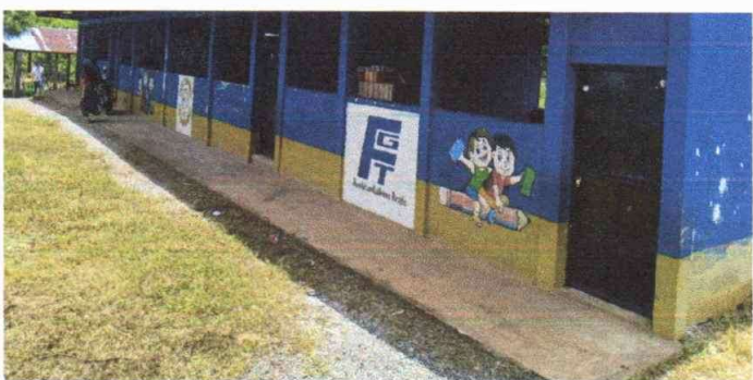
FOTO 5: Sustitución de piso de torta de concreto en el corredor
