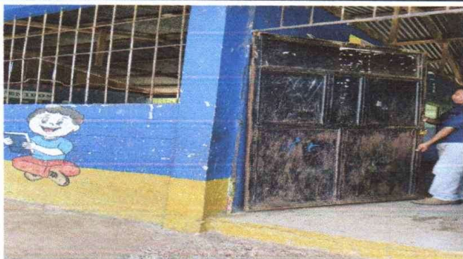
FOTO 3: Sustitución de puerta
