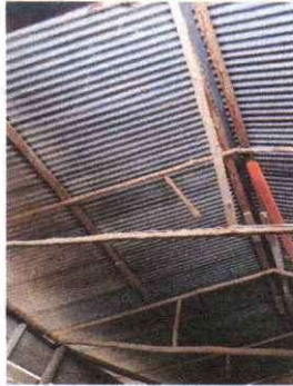
FOTO 1: SUSTITUCION DE LAMINA POR LAMINA TROQUEALDA
