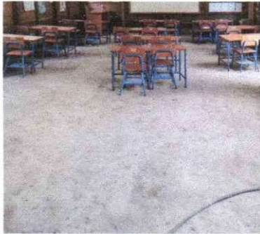
FOTO 3: REPARACION DE PISO TORTA
