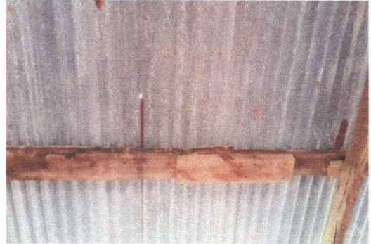
FOTO 2: SUSTITUCION DE ESTRUCTURA DE MADERA POR METAL
