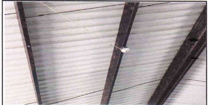
Foto 6: REPARACIÓN DE SISTEMA ELECTRICO.
