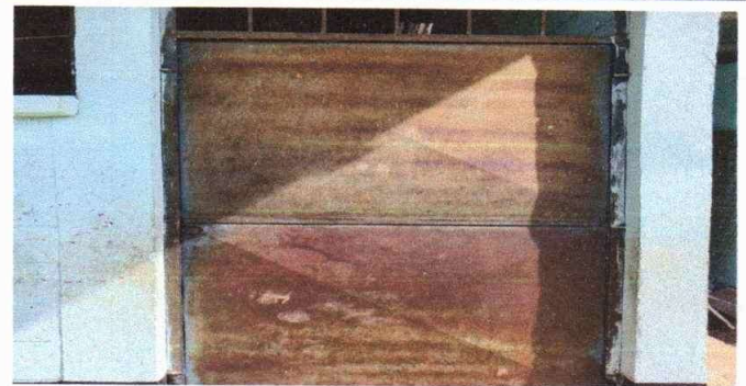
Foto 2: SUSTITUCIÓN DE PUERTA Y CHAPA.
