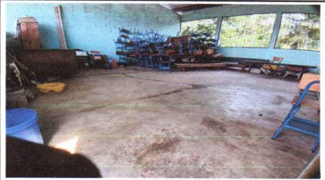
Foto 4: SUSTITUCIÓN DE PISO CERÁMICO.
