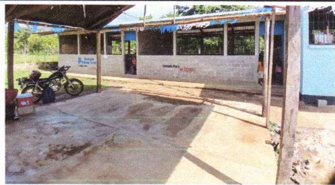
Foto 5: PINTURA EN MUROS EXTERIORES.
