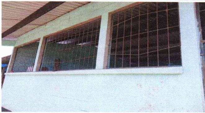
Foto 3: MANTENIMIENTO DE BALCONES DE METAL.
