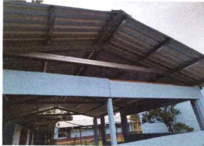
FOTO 13: REPARACION MODULO COCINA
