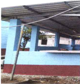
FOTO 15: PINTURA EN MUROS INTERIOR Y EXTERIOR
