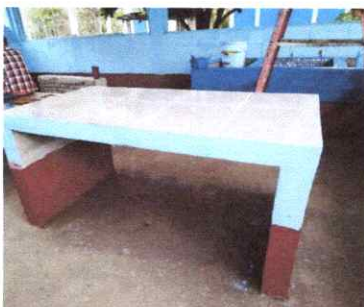
Foto 17: REPARACION DE PISO TORTA
