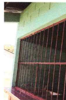
FOTO 4: MANTENIMIENTO A ESTRUCTURA DE BALCON
