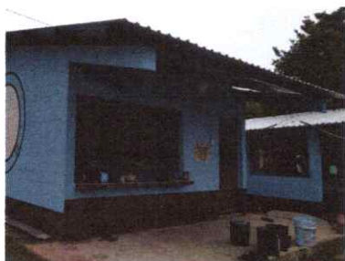
Foto 11: PINTURA EN MUROS INTERIOR Y EXTERIOR
