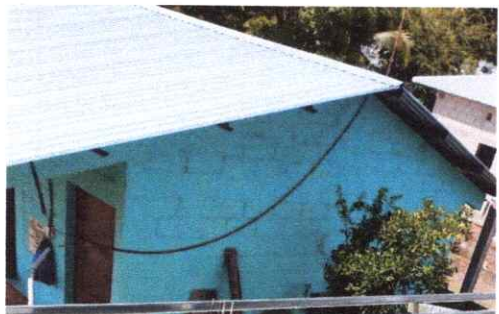
FOTO 1: SUSTITUCION DE LAMINA POR LAMINA TROQUEALDA
