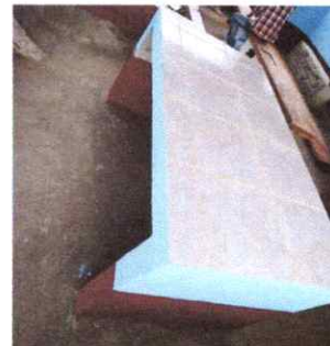
Foto 18: REPARACIÓN ESTUFA RURAL
