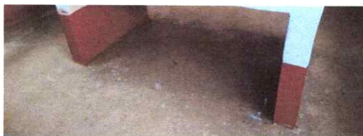
FOTO 9: REPARACION DE PISO TORTA
