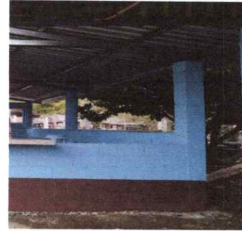
FOTO 14: REPARACION MODULO COCINA
