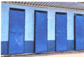
FOTO 7: MANTENIMIENTO A PUERTAS DE METAL
