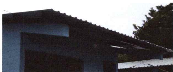
FOTO 3: SUSTITUCION ESTRUCTURA DE METAL
