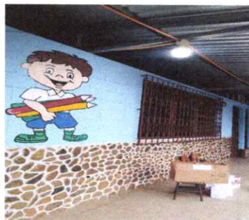
FOTO 10: PINTURA EN MUROS INTERIOR Y EXTERIOR
