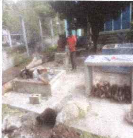
FOTO 14: REPARACION MODULO COCINA
