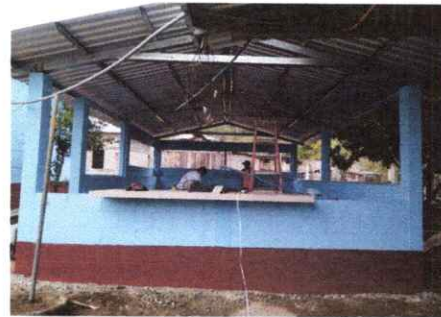
FOTO 21: REPARACION MODULO COCINA
