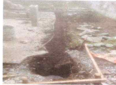
FOTO 13: REPARACION MODULO COCINA
