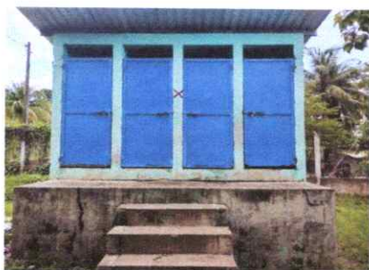
FOTO 7: MANTENIMIENTO A PUERTAS DE METAL
