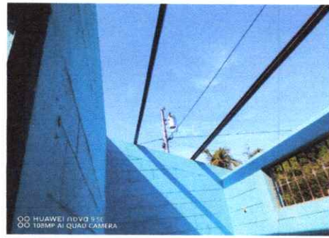
FOTO 4: SUSTITUCION ESTRUCTURA DE METAL
