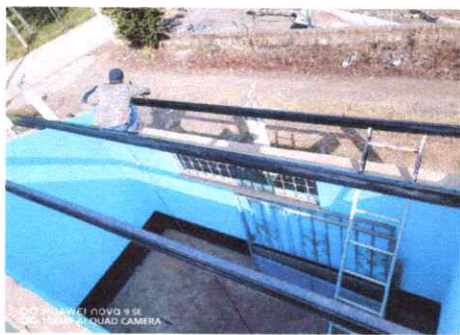
FOTO 3: SUSTITUCION ESTRUCTURA DE METAL
