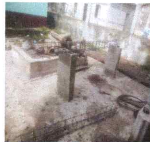
FOTO 15: REPARACION MODULO COCINA
