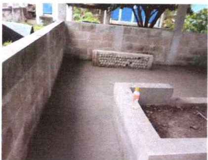
FOTO 9: REPARACION DE PISO TORTA
