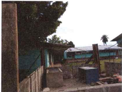
FOTO 16: REPARACION MODULO COCINA
