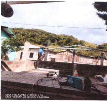
FOTO 18: REPARACION MODULO COCINA
