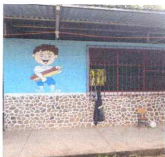
Foto 11: PINTURA EN MUROS INTERIOR Y EXTERIOR
