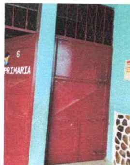
FOTO 8: MANTENIMIENTO A PUERTAS DE METAL
