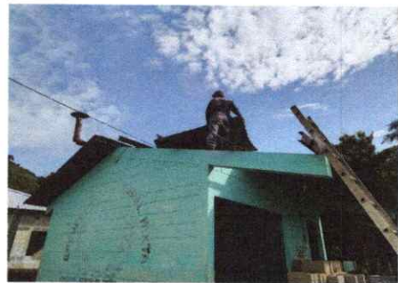
FOTO 1: SUSTITUCION DE LAMINA POR LAMINA TROQUEALDA
