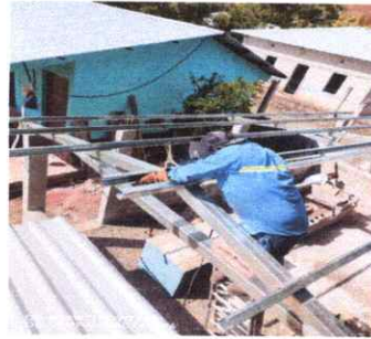
FOTO 19: REPARACION MODULO COCINA
