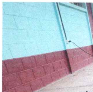
FOTO 10: PINTURA EN MUROS INTERIOR Y EXTERIOR
