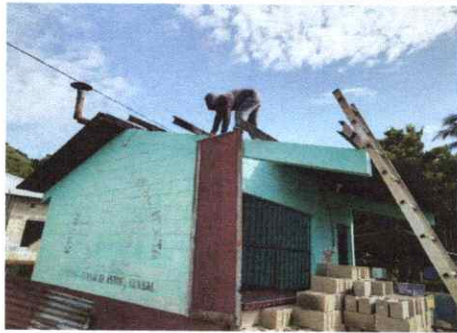
FOTO 1: SUSTITUCION DE LAMINA POR LAMINA TROQUEALDA
