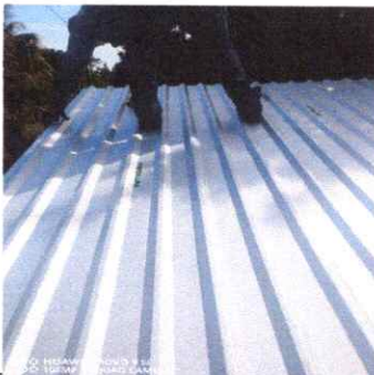
FOTO 20: REPARACION MODULO COCINA
