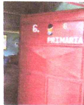
FOTO 4: MANTENIMIENTO A PUERTAS DE METAL
