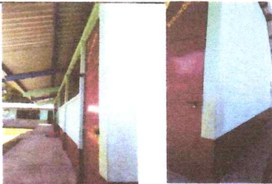
FOTO 3: PINTURA EN MUROS INTERIOR Y EXTERIOR
