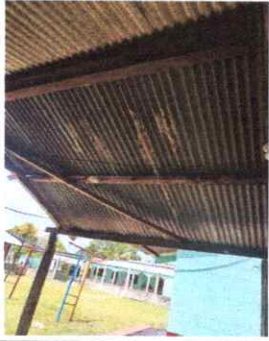
FOTO 1: REPARACION MODULO COCINA
