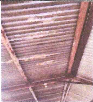
FOTO 1: SUSTITUCION DE LAMINA POR LAMINA TROQUEALDA
