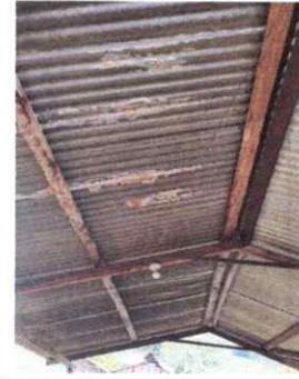
FOTO 2: REPARACION MODULO COCINA
