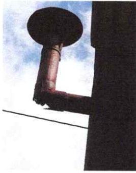
FOTO 3: REPARACION MODULO COCINA
