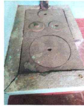
FOTO 4: REPARACION MODULO COCINA
