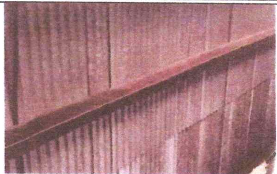
FOTO 2: SUSTITUCION DE ESTRUCTURA DE MADERA POR METAL
