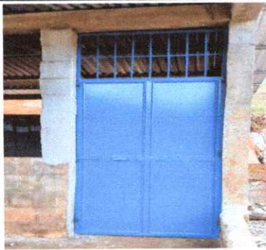
FOTO 3: SUSTITUCIÓN DE PUERTA DE MADERA A METAL...
