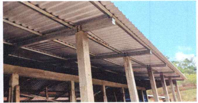
FOTO 2. SUSTITUCIÓN DE ESTRUCTURAS DE MADERA POR METAL.
