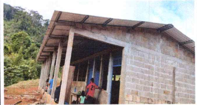
FOTO 4: LEVANTAMIENTO DE PARED.
