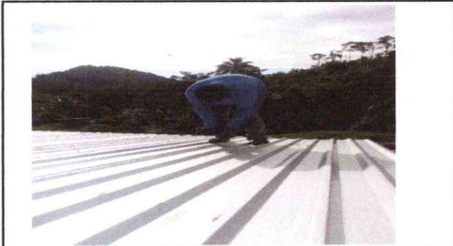
FOTO 1: SUSTITUCIÓN DE LAMINA POR LAMINA TROQUELADA.
