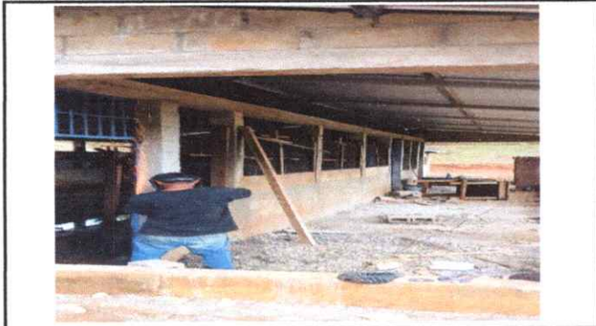
FOTO 3: SUSTITUCIÓN DE PUERTA DE MADERA A METAL.
