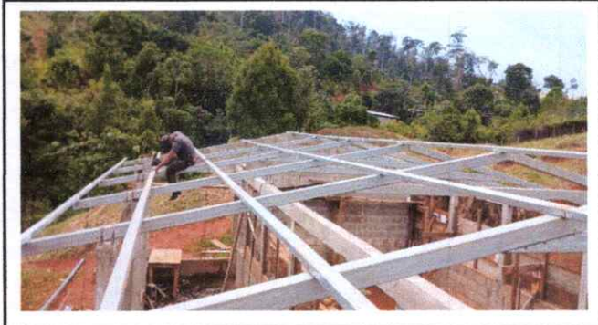
FOTO 2: SUSTITUCIÓN DE ESTRUCTURA DE MADERA POR METAL.
