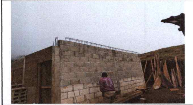
FOTO 4: LEVANTAMIENTO DE PARED.
