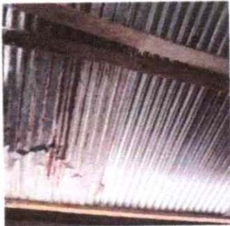
FOTO 1: SUSTITUCION DE LAMINA POR LAMINA TROQUEALDA
