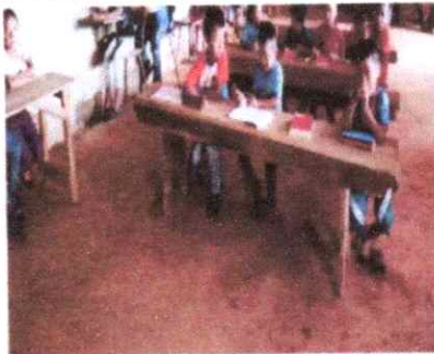
FOTO 3: REPARACION DE PISO TORTA
