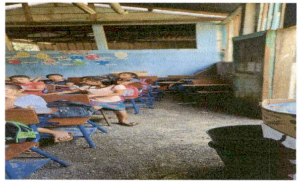
Foto 8: SUMINISTRO E INSTALACION DE PISO CERAMICO ANTIDESLIZANTE.
