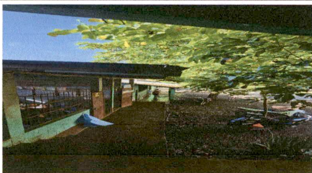
Foto 5: REPARACION DE CUNETA DE CONCRETO PARA CANALIZACION DE AGUAS PLUVIALES
