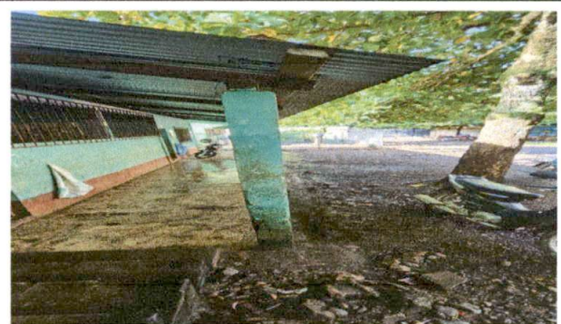
Foto 6: REPARACION DE CUNETA DE CONCRETO PARA CANALIZACION DE AGUAS PLUVIALES.
