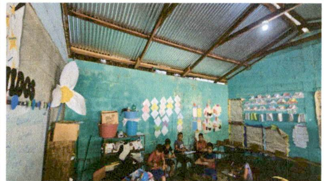
Foto 10: SUMINISTRO E INSTALACION DE ESTRUCTURA METALICA
