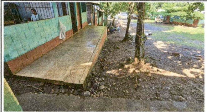
Foto 4: REPARACION DE BANQUETA DE CONCRETO Y PROTECCION DE FILTRACION DE AGUA.
