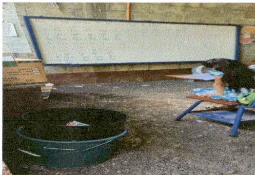
Foto 9: SUMINISTRO E INSTALACION DE PISO CERAMICO ANTIDESLIZANTE.
