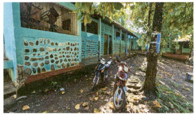
Foto 2: REPARACION DE BANQUETA DE CONCRETO Y PROTECCION DE MUROS PARA FILTRACION DE AGUA.
