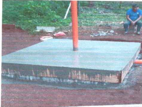
FOTO 1: REMODELACION DE LEVANTAMIENTO DE MURO PARA FOSA SEPTICA
