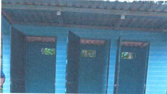
FOTO 7: PINTURA EN MUROS INTERIORES DE SANITARIOS
