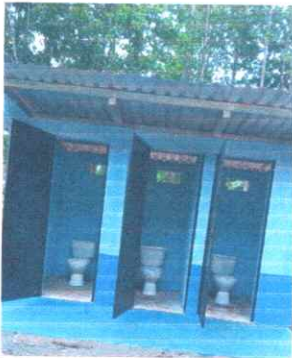
FOTO 9: SUSTITUCION DE INODORO
