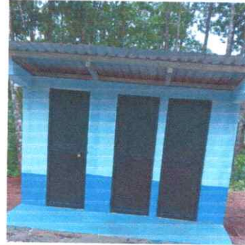
FOTO 8: PINTURA EN MUROS EXTERIORES DE SANITARIOS
