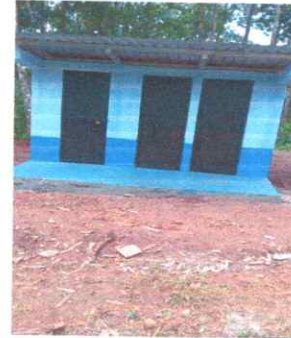
FOTO 2: LEVANTAMIENTO DE MURO PARA SANITARIO
