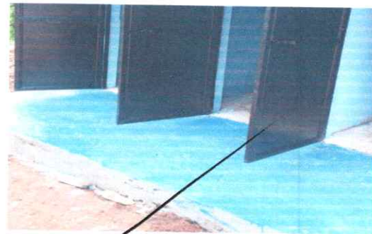
FOTO 6: SUSTITUCION DE PISO DE TORTA DE CONCRETO EN SANITARIOS
