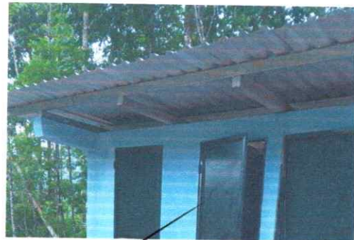
FOTO 4: SUSTITUCION DE ESTRUCTURA METALICA EN TECHO DE SANITARIOS
