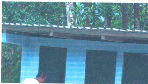
FOTO 3: SUSTITUCION DE LAMINA TROQUELADA EN SANITARIOS
