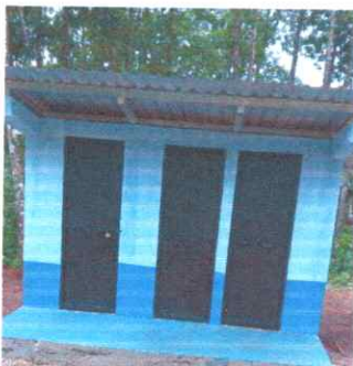
FOTO 5: SUSTITUCION DE PUERTA DE METAL DE SANITARIOS
