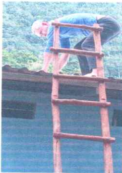
FOTO 3: SUSTITUCION DE LAMINA TROQUELADA EN SANITARIOS
