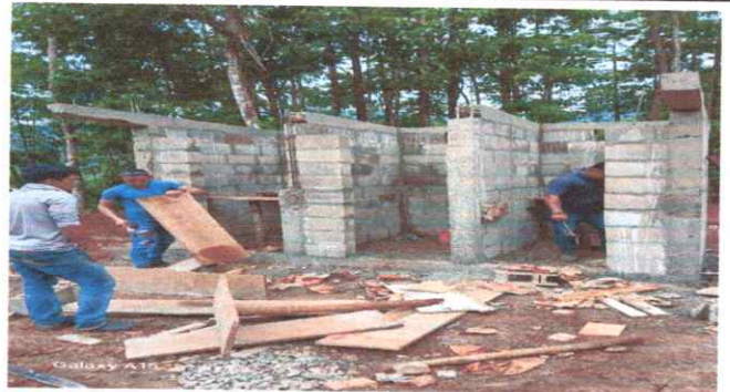
FOTO 2: LEVANTAMIENTO DE MURO PARA SANITARIO
