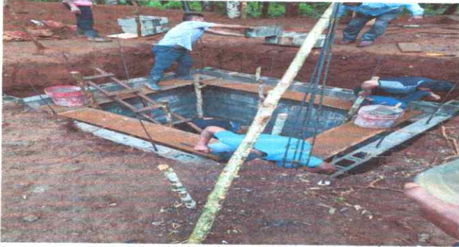
FOTO 1: REMODELACION DE LEVANTAMIENTO DE MURO PARA FOSA SEPTICA
