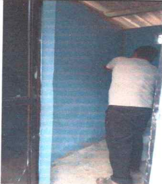
FOTO 7: PINTURA EN MUROS INTERIORES DE SANITARIOS
