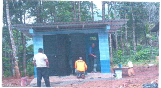
FOTO 8: PINTURA EN MUROS EXTERIORES DE SANITARIOS
