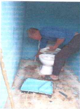
FOTO 9: SUSTITUCION DE INODORO
