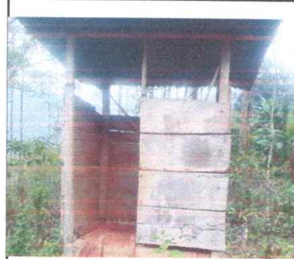
Foto 4: Reparación de piso de torta de concreto en sanitarios.
