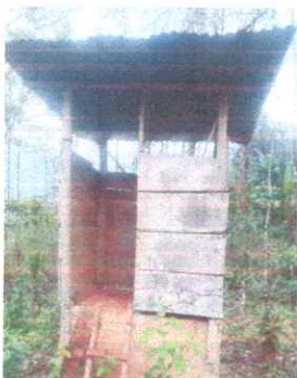
Foto 5: Pintura en muros exteriores e interiores Sanitario
