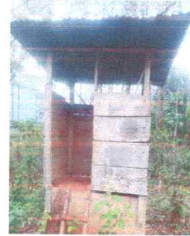
Foto 2: Mantenimiento a estructura de soporte de metal en techo de sanitarios
