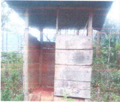
Foto 3: Sustitución de puertas de sanitarios.
