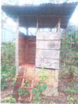
Foto 1: Sustitución de lámina, por lámina troquelada aluzinc calibre 26 en techo de sanitarios.
