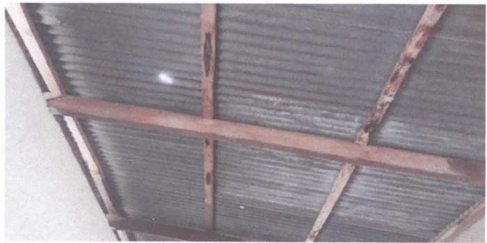
Proyecto 3. Cambio de estructura de madera por estructura metálica
