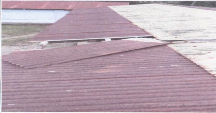
Proyecto 1. Cambio de láminas deterioradas por láminas troqueladas de aluzinc
