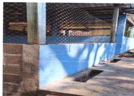
FOTO 6: REMODELACION Y LEVANTADO DE PARED EN COCINA
