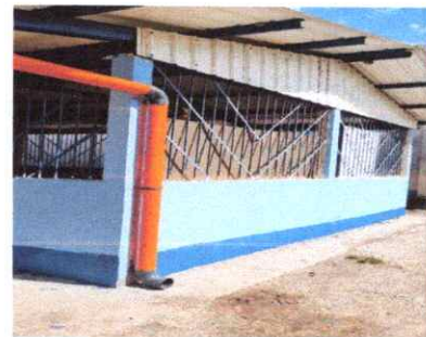
FOTO 10: PINTURA MURO EXTERIOR
