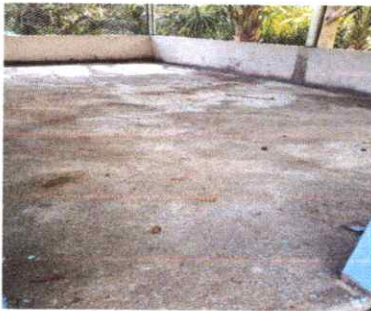
FOTO 3: REPARACION DE PISO TORTA DE CONCRETO
