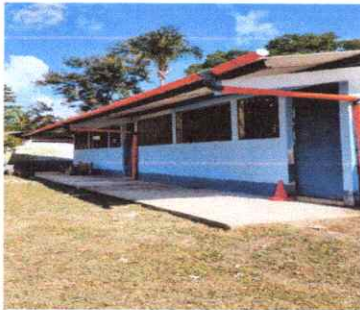
FOTO 9: PINTURA MURO EXTERIOR
