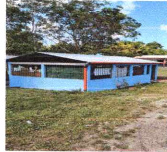
FOTO 8: PINTURA MURO EXTERIOR
