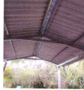
FOTO 2: SUSTITUCION DE ESTRUCTURA DE SOPORTE DE METAL
