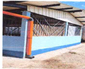
FOTO 4: SUSTITUCION DE CANALES
