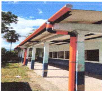
FOTO 5: SUSTITUCION DE CANALES
