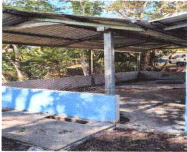
FOTO 7: REMODELACION Y LEVANTADO DE PARED EN COCINA
