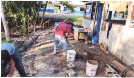
FOTO 3: REPARACION DE PISO TORTA DE CONCRETO
