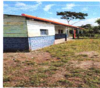
FOTO 4: SUSTITUCION DE CANALES
