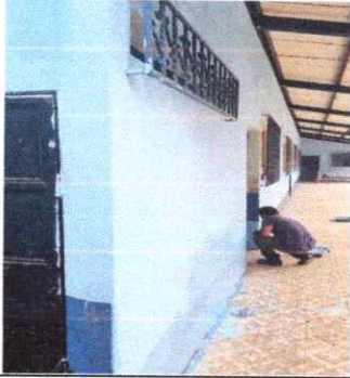
FOTO 7: PINTURA MURO EXTERIOR
