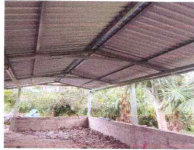
FOTO 2: SUSTITUCION DE ESTRUCTURA DE SOPORTE DE METAL
