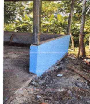
FOTO 8: PINTURA MURO EXTERIOR
