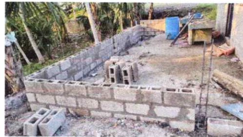
FOTO 6: REMODELACION Y LEVANTADO DE PARED EN COCINA
