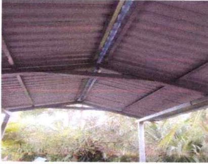
FOTO 1: SUSTITUCION DE LAMINA POR LAMINA TROQUEALDA
