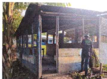
FOTO 2: REMODELACION Y LEVANTADO DE PARED EN COCINA
