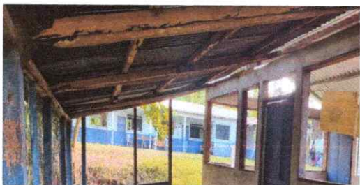
FOTO 3: SUSTITUCION E INSTALACION DE ESTRUCTURA DE METAL
