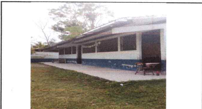
FOTO 4: SUSTITUCION DE CANALES
