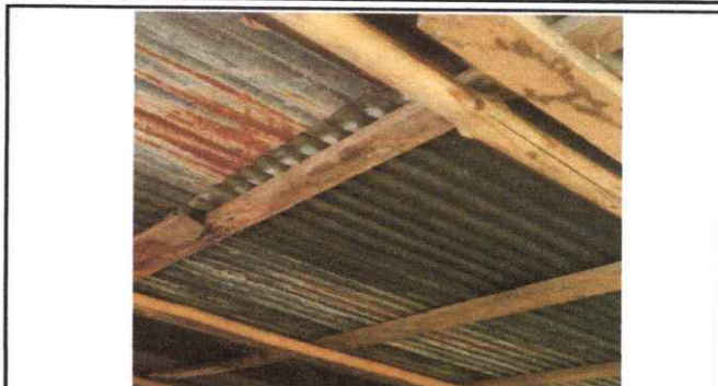
FOTO 2: MANTENIMIENTO A ESTRUCTURA DE METAL
