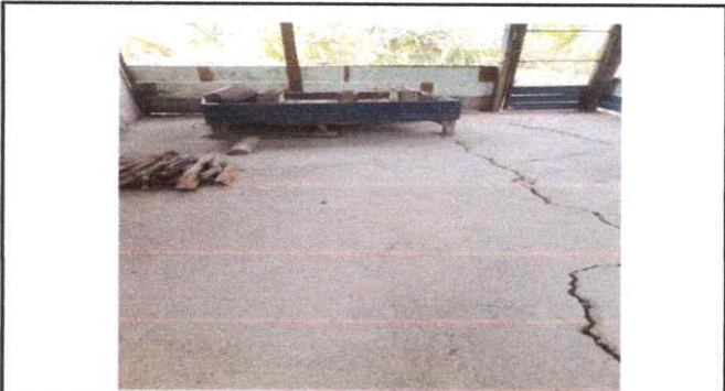
FOTO 3: REPARACION DE PISO TORTA DE CONCRETO
