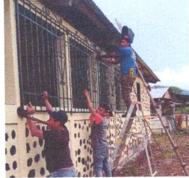
FOTO 2: Sustitución de balcones
