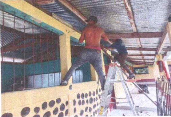
FOTO 1: Sustitución de balcones
