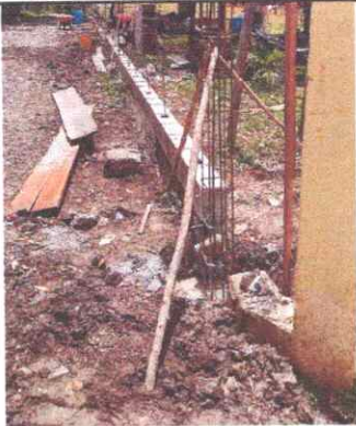
FOTO 3: Reparación de muro perimetral
