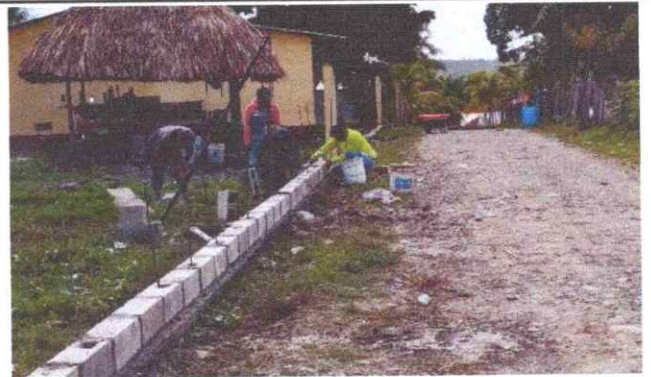
FOTO 4: Reparación de muro perimetral
