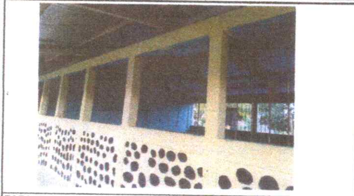
FOTO 1: Sustitución de balcones
