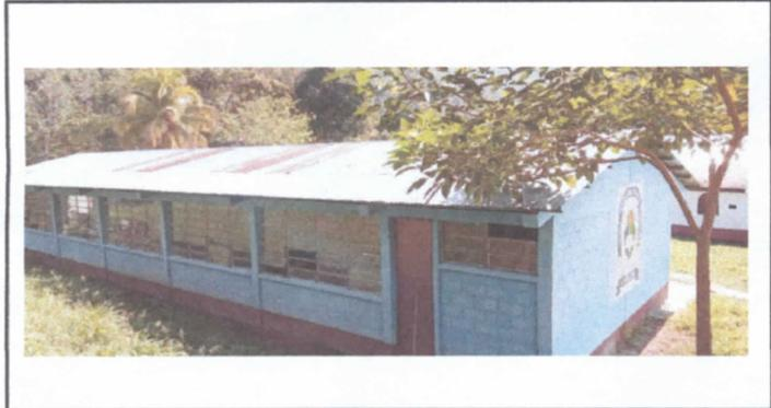
FOTO 1: SUSTITUCION DE LAMINA POR LAMINA TROQUELADA
