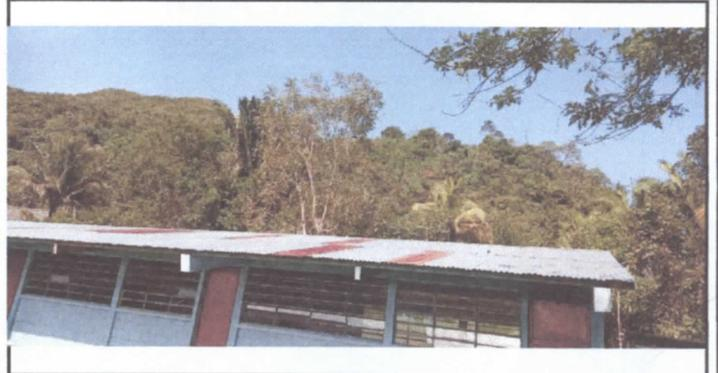
FOTO 2: SUSTITUCION DE LAMINA POR LAMINA TROQUELADA
