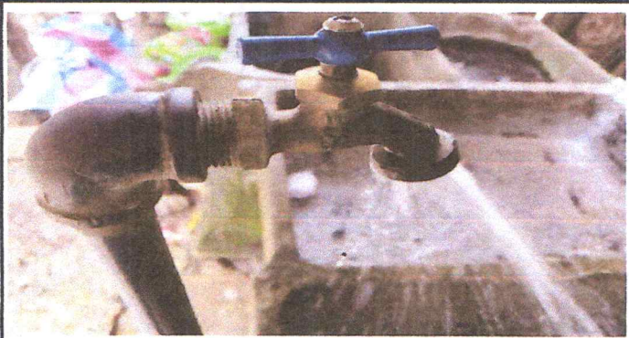
Foto 9: sustitucion de tuveria linea principal / sustitucion de llave de chorro / sustitucion de llave de cheque
