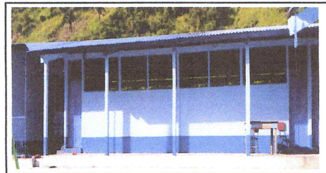
Foto 6: pintura en muros exteriores e interiores.
