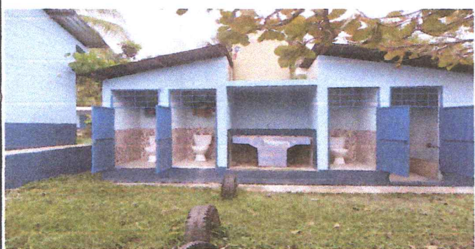
Foto7: sustitucion de inodoro / sustitucion de grifos
