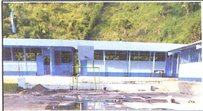
Foto1: SUSTITUCION DE LAMINAS
