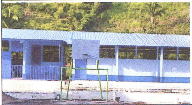
Foto 2: SUSTITUCION DE LAMINAS
