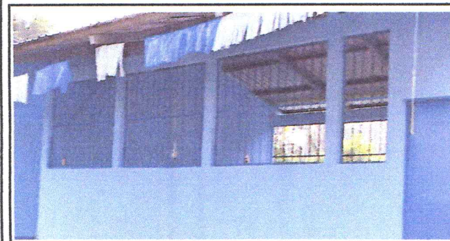
Foto 5: mantenimientos de de balcones de metal
