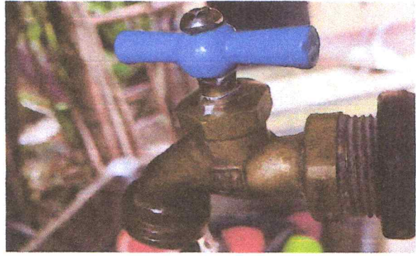
Foto 8: sustitucion de tuveria linea principal / sustitucion de llave de chorro / sustitucion de llave de cheque
