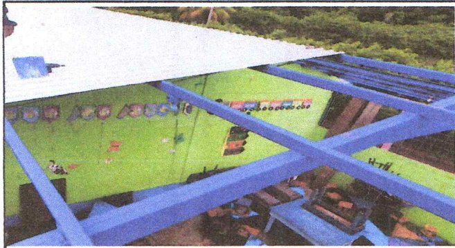
Foto1: SUSTITUCION DE LAMINAS
