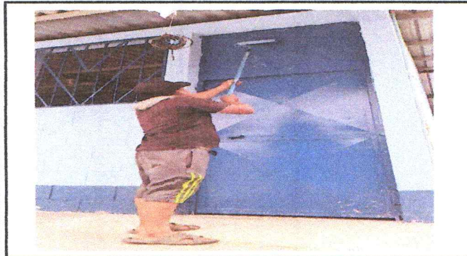
Foto 3: mantenimiento a estructura (lijado, cambio de tuvo, cepillado, sujecciones, aplicación de pintura)
