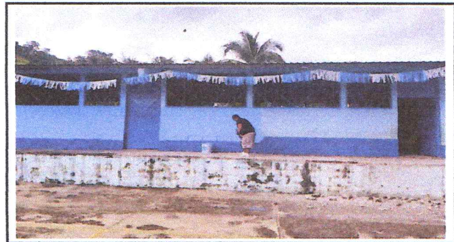
Foto 6: pintura en muros exteriores e interiores.
