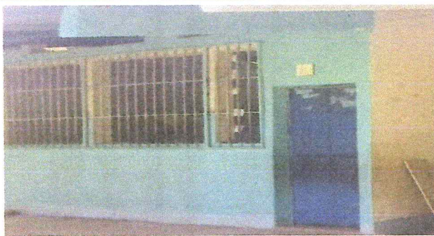
Foto 5: mantenimientos de de balcones de metal
