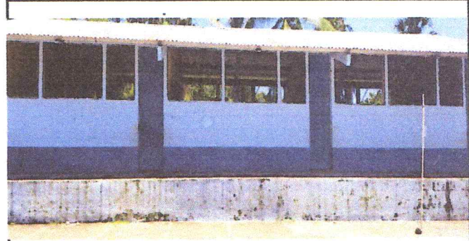
Foto 6: pintura en muros exteriores e interiores.
