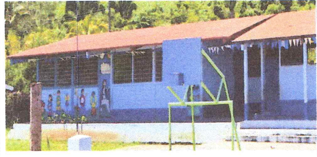
Foto 2: SUSTITUCION DE LAMINAS
