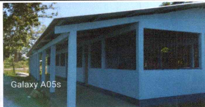
Foto 4: mejoramiento de base de concreto
