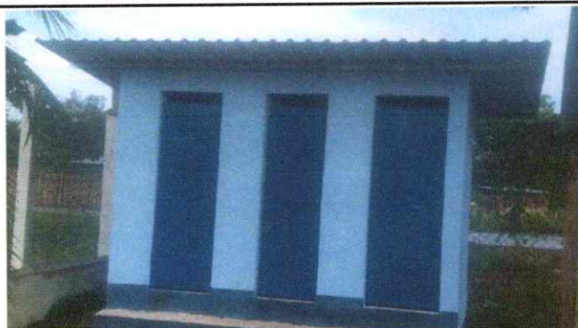
Foto 3: Remozamiento total de sanitarios
