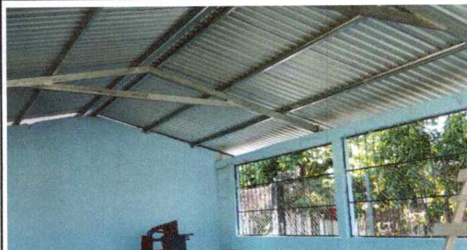
Foto 2: Sustitución de estructura de soporte de madera
