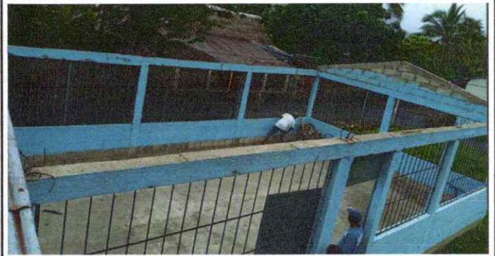
Foto 2: Sustitución de estructura de soporte de madera.
