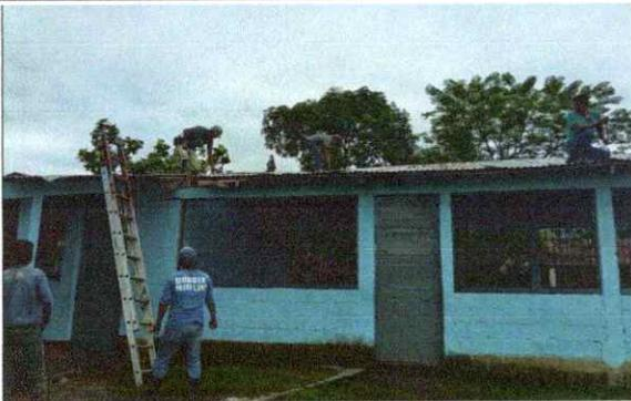
Foto 1: Sustitución de lámina, por lámina troquelada aluzinc calibre 26, en aulas y baños
