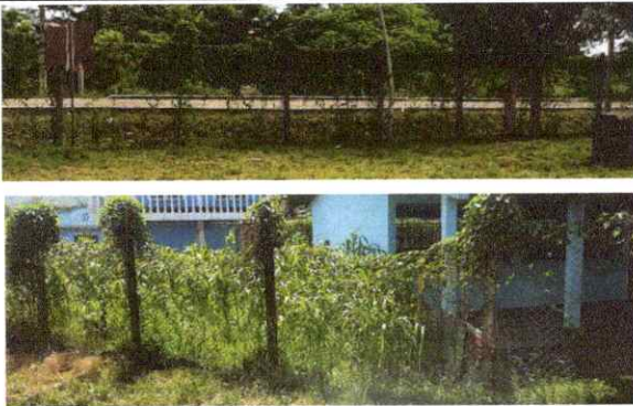
Foto 3: Reparación de tubo hg y malla galvanizada
