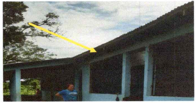
Foto 2: Sustrucción de estructura de soporte de madera.
