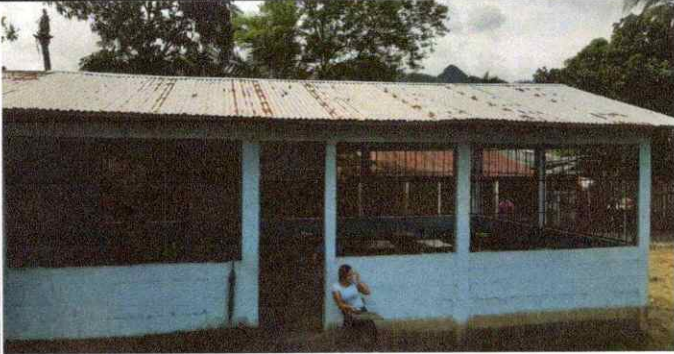
Foto 1: Sustrucción de lámina, por lámina troquelada aluzinc calibre 26, en aulas y baños
