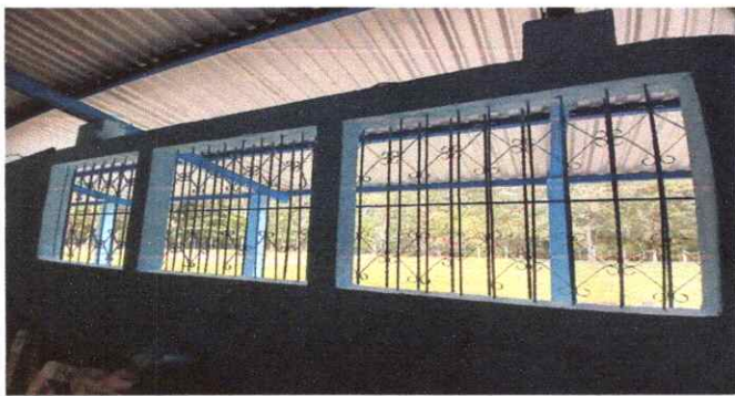
FOTO 3: MANTEMIENTO A BALCONES
