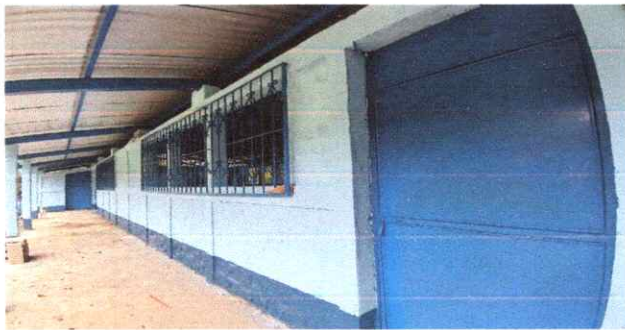
FOTO 5: PINTURA EN MURO INTERIOR Y EXTERIOR
