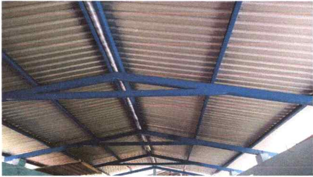
FOTO 1: MANTENIMIENTO A ESTRUCTURA DE METAL
