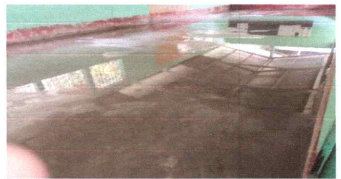
FOTO 4: REPARACION DE PISO TORTA
