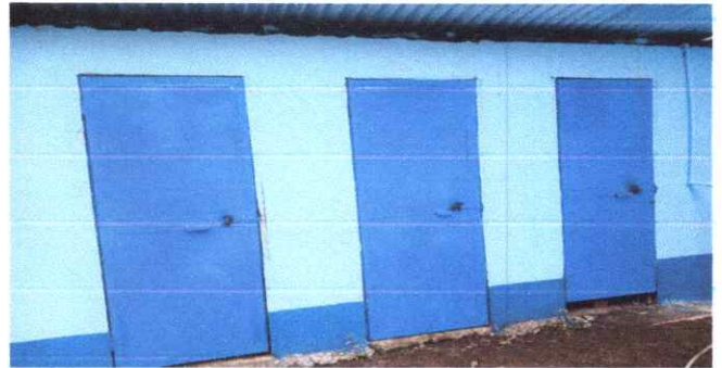
FOTO 2: SUSTITUCION DE PUERTAS DE MADERA POR METALICA
