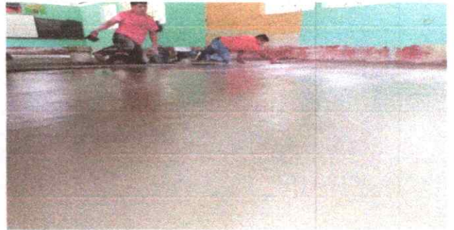
FOTO 4: REPARACION DE PISO TORTA
