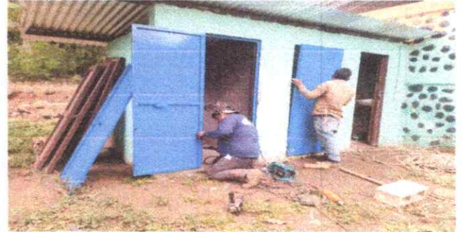
FOTO 2: SUSTITUCION DE PUERTAS DE MADERA POR METALICA
