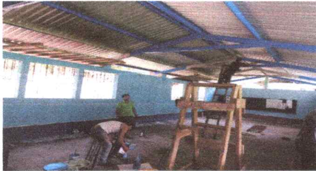
FOTO 1: MANTENIMIENTO A ESTRUCTURA DE METAL
