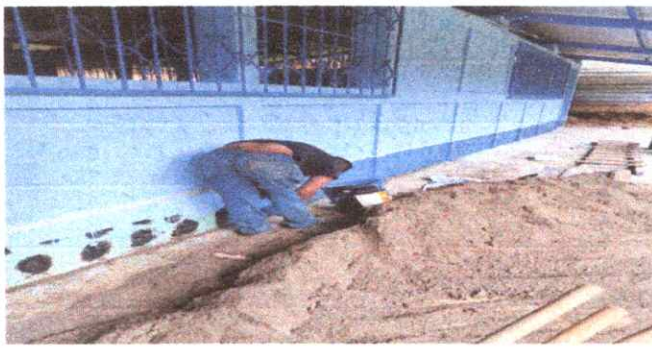
FOTO 5: PINTURA EN MURO INTERIOR Y EXTERIOR
