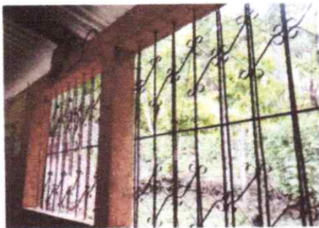
FOTO 3: MANTENIMIENTO A BALCONES
