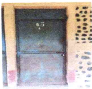
FOTO 5: PINTURA EN MUROS INTERIOR Y EXTERIOR
