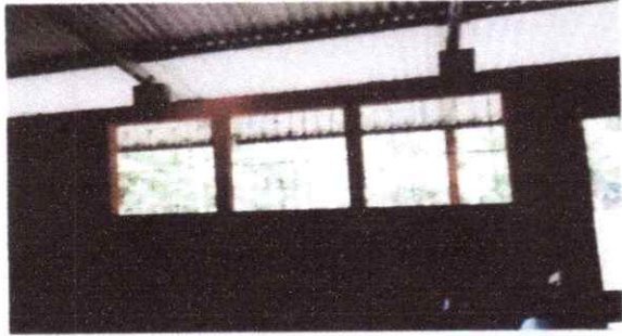
FOTO 1: MANTENIMIENTO A ESTRUCTURA DE METAL
