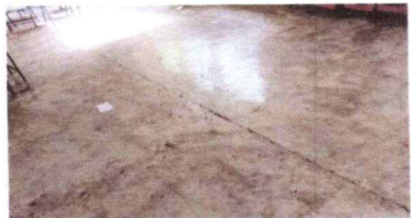
FOTO 4: REPARACION DE PISO TORTA
