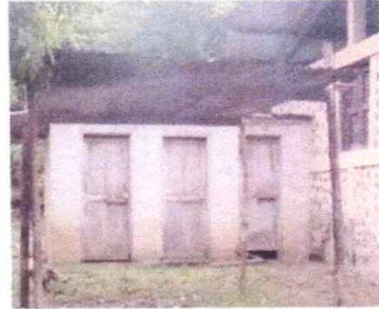
FOTO 2: SUSTITUCION DE PUERTAS DE MADERA POR METAL
