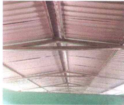
FOTO 3: SUSTITUCIÓN DE ESTRUCTURA DE SOPORTE DE MADERA POR METAL
