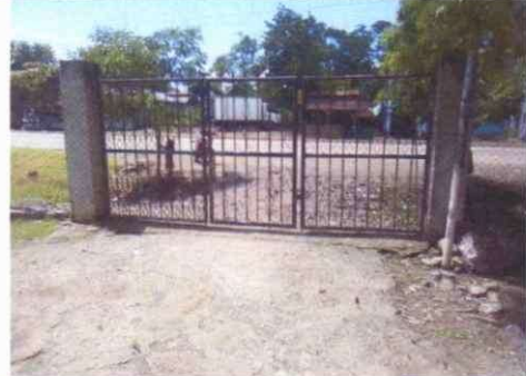
Foto 2: Sustrutitución de portón de metal
