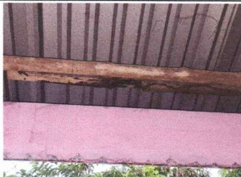
FOTO 2: SUSTITUCION DE ESTRUCTURA DE METAL
