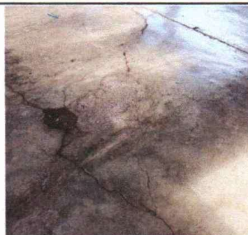
FOTO 5: REPARACION PISO TORTA DE CONCRETO
