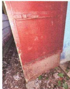
FOTO 5: SUSTITUCION DE PUERTAS DE METAL
