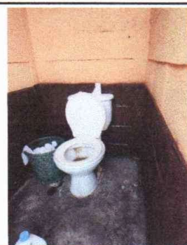
FOTO 6: SUSTITUCION DE SANITARIOS
