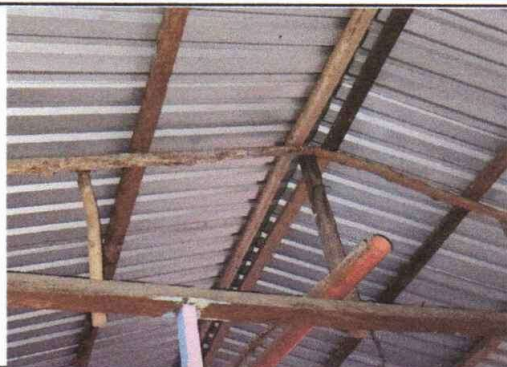
FOTO 1: SUSTITUCION DE ESTRUCTURA DE METAL
