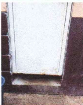
FOTO 3: MANTENIMIENTO DE PUERTAS DE METAL
