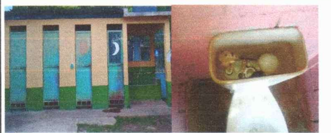
Foto 5: SUSTITUCIÓN DE ACCESORIOS INODORO.
