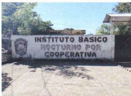
Foto 5: PINTURA MURO INTERIOR Y EXTERIOR
