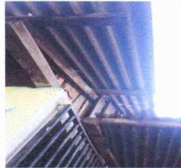
FOTO 2: SUSTITUCION DE ESTRUCTURA DE MADERA POR METAL
