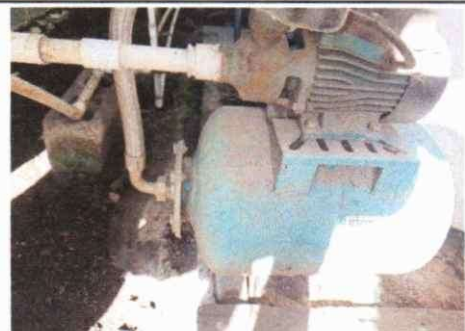
Foto 6: SUSTITUCION DE BOMBA DE AGUA
