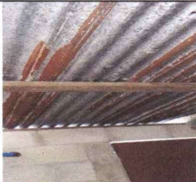
FOTO 1: SUSTITUCION DE LAMINA POR LAMINA TROQUEALDA
