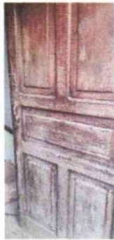
FOTO 3: SUSTITUCION DE PUERTAS DE MADERA POR METAL
