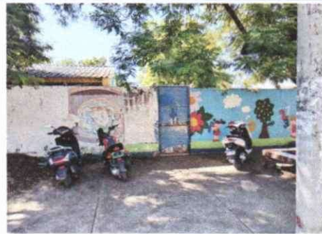
FOTO 4: PINTURA MURO INTERIOR Y EXTERIOR
