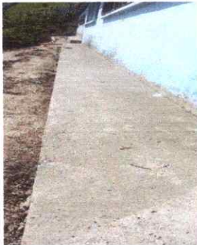
FOTO 5: Reparación de banqueta de concreto
