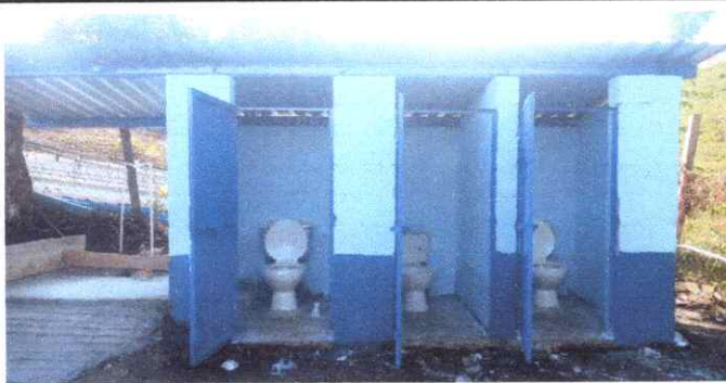
FOTO 3: Sustitución de puerta en servicio sanitarios
