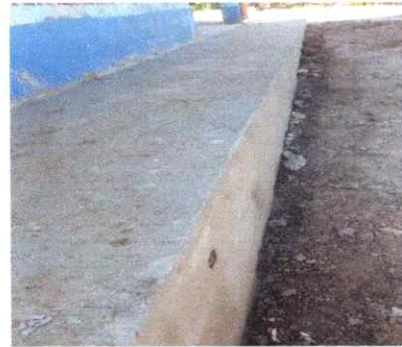
FOTO 4: Reparación de banqueta de concreto
