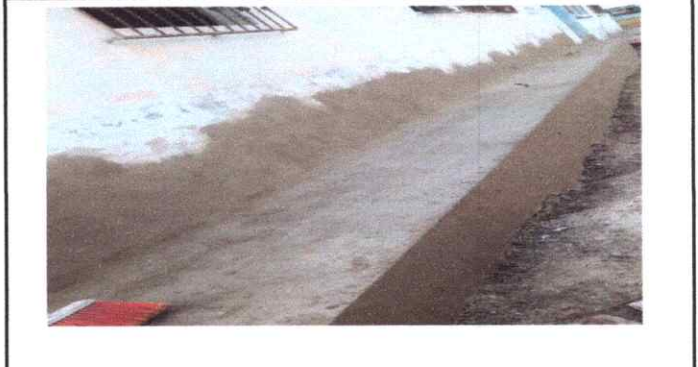
FOTO 8: Aplicación de repello de muro de contención
