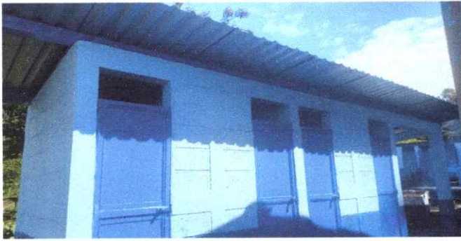
FOTO 1: Sustitución de lámina troquelada aluzinc calibre 26
