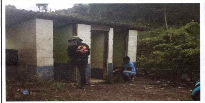
Foto 3: sustirución de puerta en servicio sanitarios
