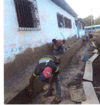
FOTO 8: Aplicación de repello de muro de contención
