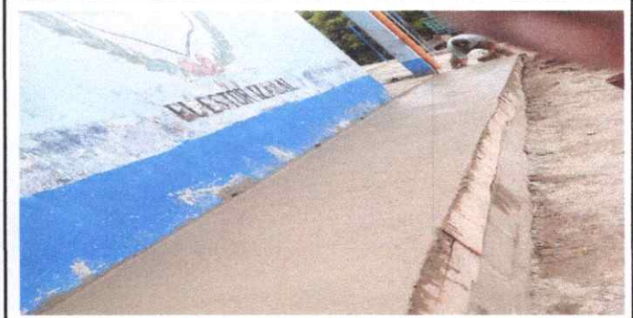
Foto 4: reparación de banquetas de concreto
