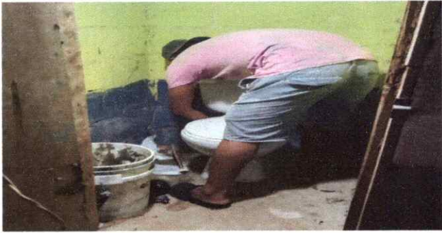
FOTO 7: Sustitución de inodoro
