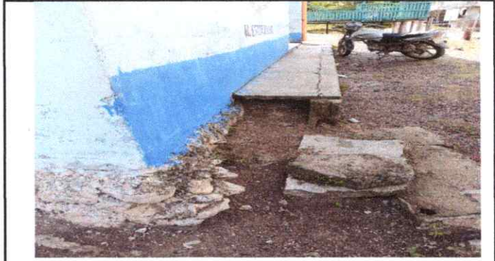
Foto 4: Reparación de banquetas de concreto
