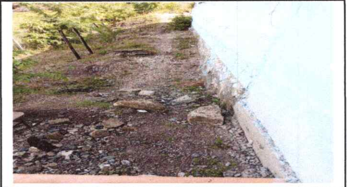
Foto 2: Aplicación de repello de muro de contención
