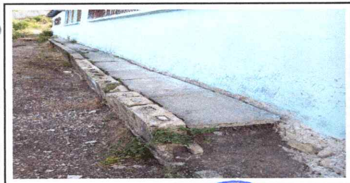
Foto 5: Reparación de banquetas de concreto.
