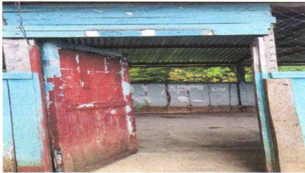
Foto 3: Sustrucción de puerta.
