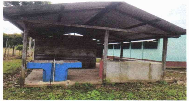
Foto 2: Sustrucción de estructura de techo de madera, por metal.
