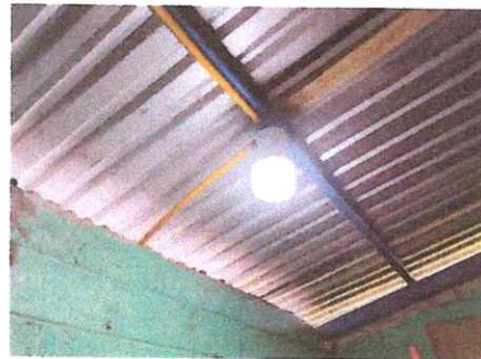
Foto 4: REPARACION SISTEMA ELECTRICA
