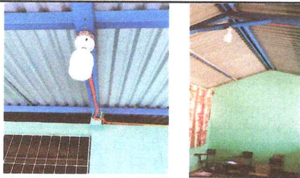
Foto 5: REPACION SISTEMA ELECTRICA
