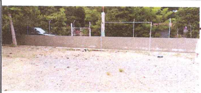
Foto 2: REPELLO EN MURO
