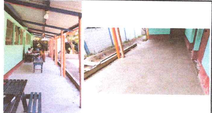
Foto 2: SUSTITUCION DE PISO TORTA
