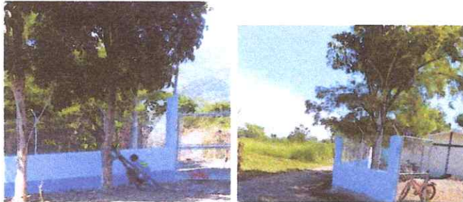
Foto1: PINTURA EN MUROS INTERIOR Y EXTERIOR
