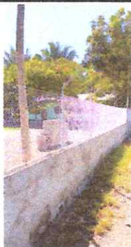
Foto 3: REPELLO EN MURO
