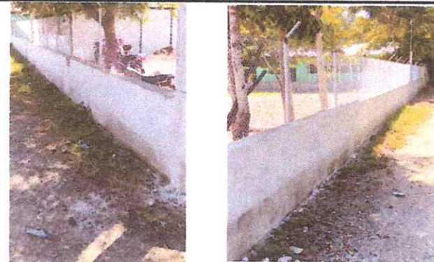
Foto 3: REPARACION MURO PERIMETRAL
