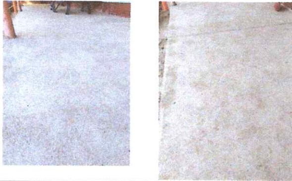
Foto 1: SUSTITUCION DE PISO TORTA
