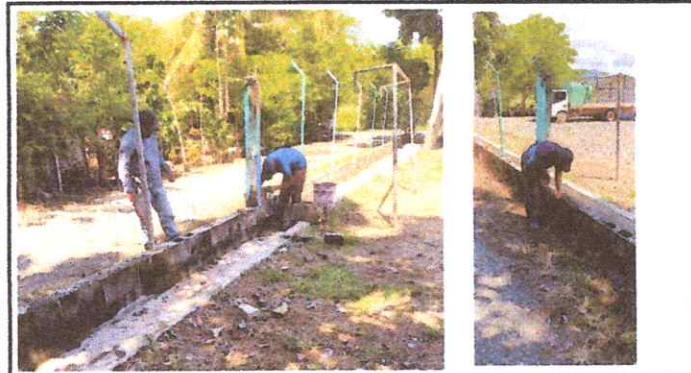
Foto 3: REPARACION MURO PERIMETRAL
