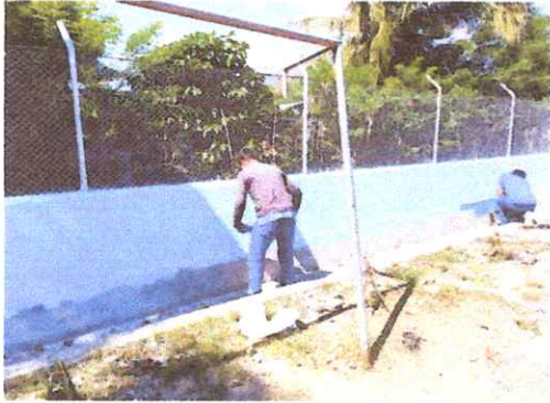
Foto1: PINTURA EN MUROS INTERIOR Y EXTERIOR
