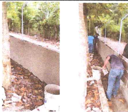
Foto 3: REPELLO EN MURO
