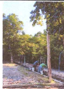
Foto 4: REPELLO EN MURO
