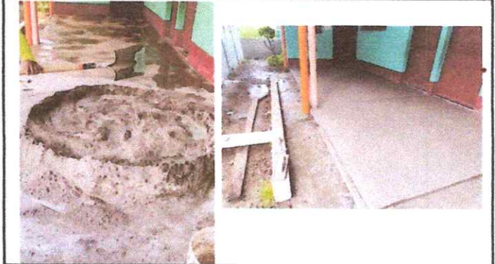
Foto 2: SUSTITUCION DE PISO TORTA
