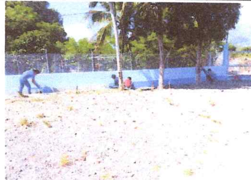
Foto 2: PINTURA EN MUROS INTERIOR Y EXTERIOR
