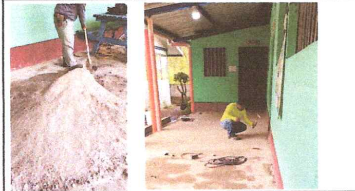
Foto1: SUSTITUCION DE PISO TORTA
