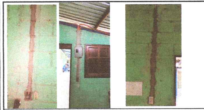
Foto 5: REPACION SISTEMA ELECTRICA
