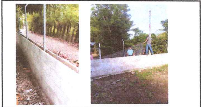
Foto 4: REPARACION MURO PERIMETRAL
