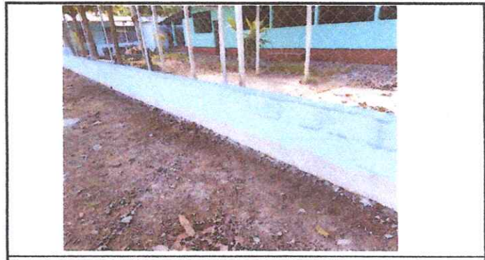
Foto 6: PINTURA EN MUROS INTERIOR Y EXTERIOR
