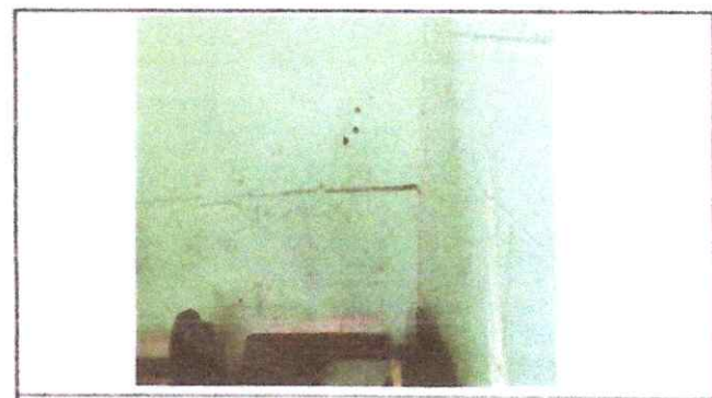
FOTO 4: REPELLO EN PAREDES
