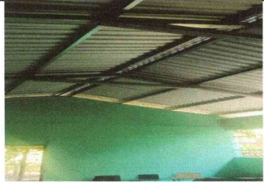
FOTO : SUSTITUCION ESTRUCTURA DE METAL
