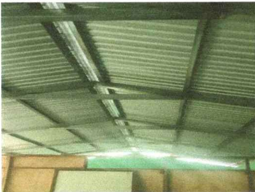
FOTO 3: SUSTITUCION DE LAMINA TROQUELADA CAL. 26
