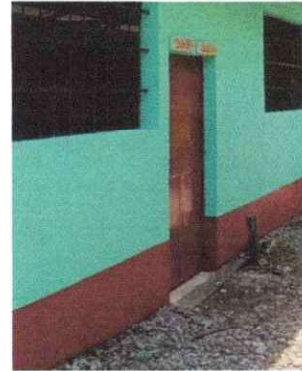
FOTO 4: SUSTITUCION DE PUERTA DE METAL
