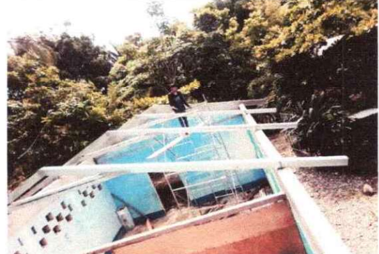
FOTO 4: SUSTITUCION DE ESTRUCTURA DE MADERA POR METAL
