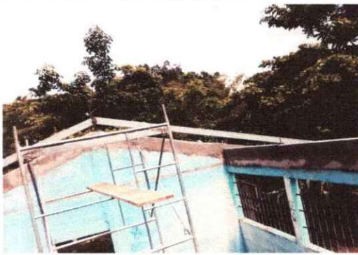
FOTO 3: SUSTITUCION ESTRUCTURA DE MADERA POR METAL
