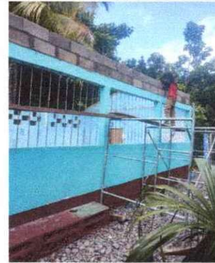
FOTO 2: LEVANTAMIENTO ALTURA DE MODULO AULA
